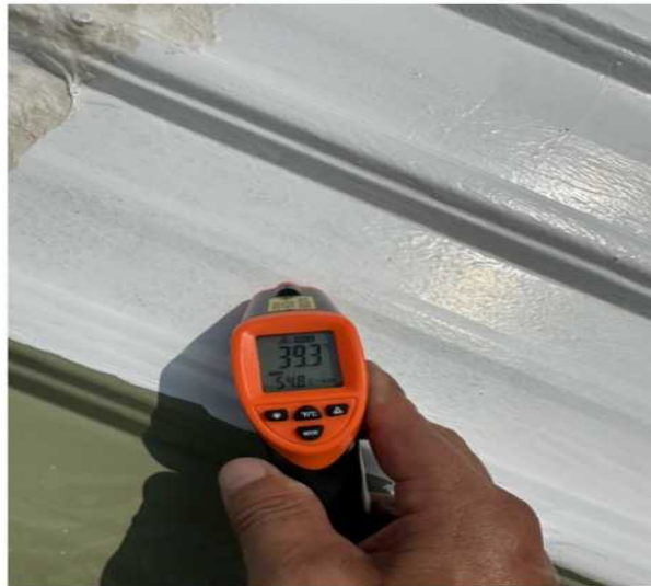
112年10月23日屋頂綠色浪板使用隔熱漆後溫度 (39.3度)
