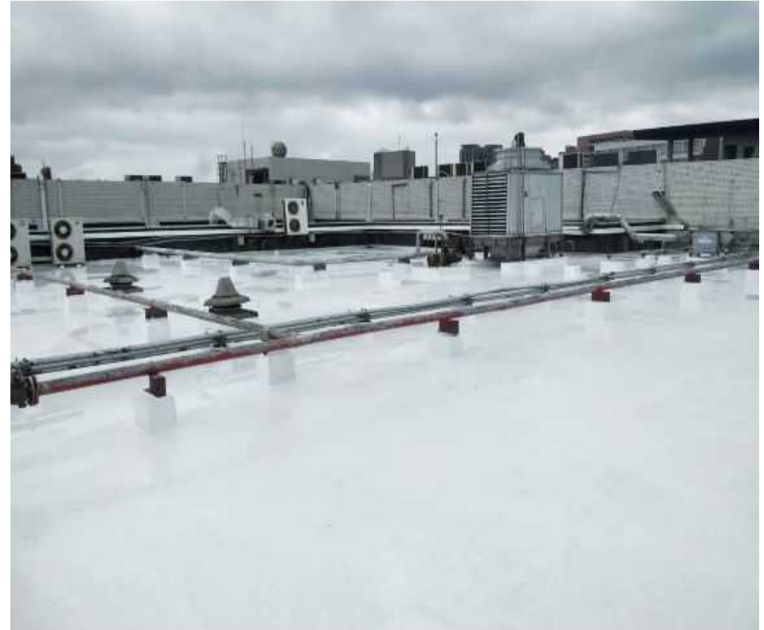
長庚科大屋頂 PU防水材+隔熱漆
