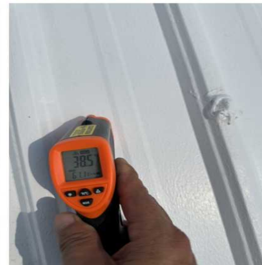
112年10月23日屋頂白色浪板使用隔熱漆後溫度 (38.5度)
