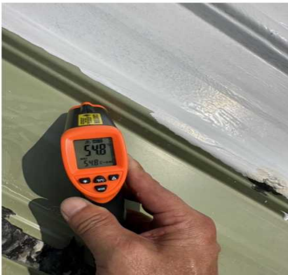
112年10月23日屋頂綠色浪板使用隔熱漆前溫度 (54.8度)
